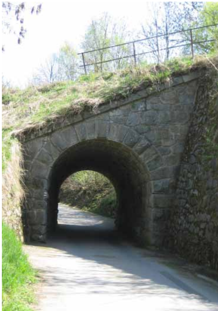
12. Viadukt u Malenic. Foto OÚ Malenice
